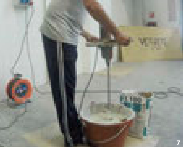
Preparazione del collante · Adhesive preparation
